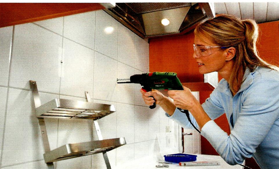
Wiercenie otworów na kołki.
